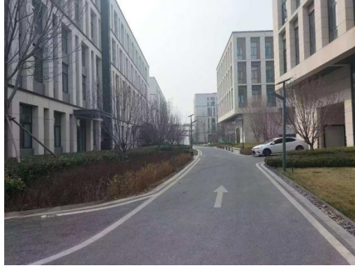
项目北侧照片
